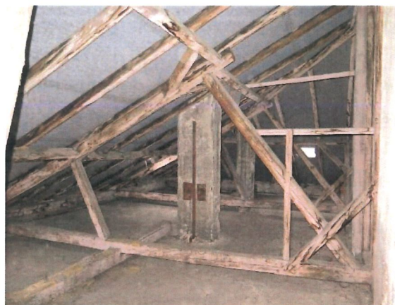
Obr. 5 - Pohled do prostoru krovu nad zadní budovou na ulici Vodní
