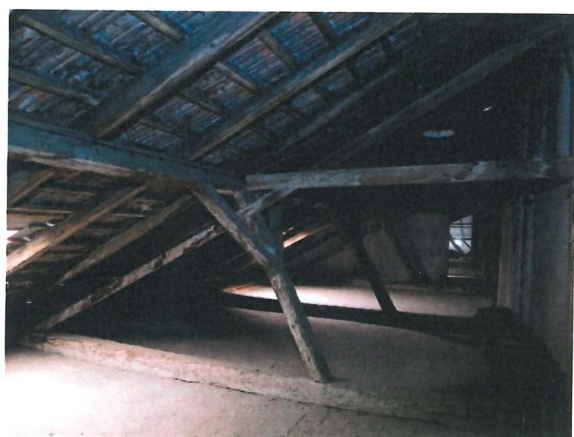
Obr. 3 - Pohled do prostoru krovu první části pultové střechy nad dvorním traktem
